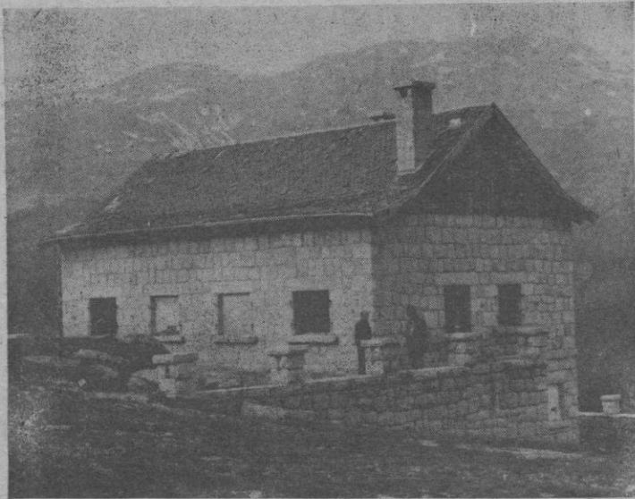
En la fotografía, una vista del edificio principal.
