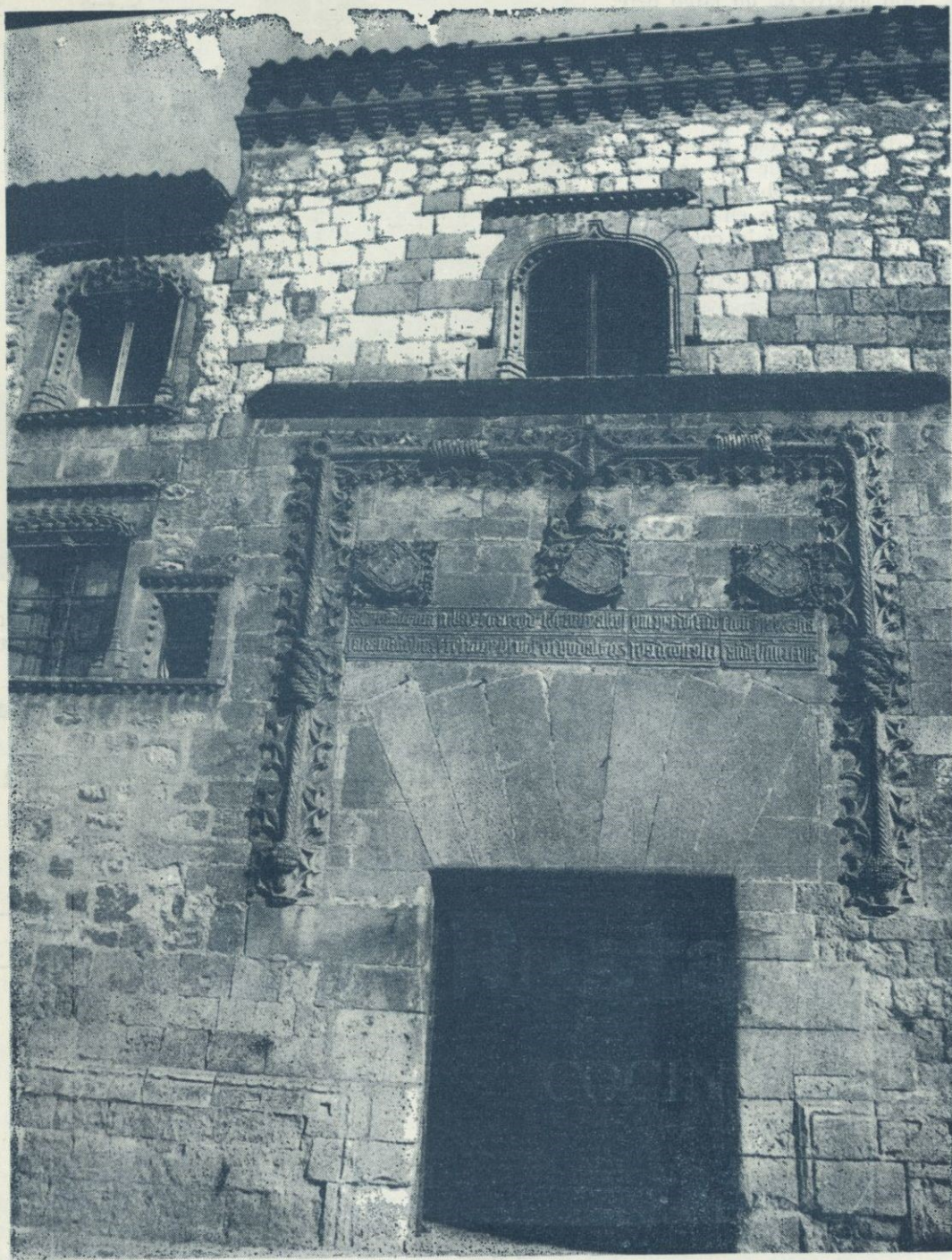
Vista de la fachada principal del palacio de los Contreras, uno de los símbolos de la historia de la villa.
