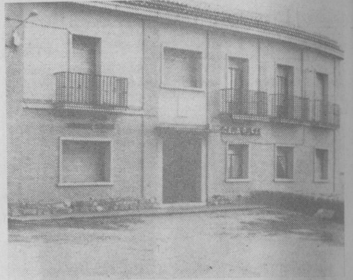
Vista de la fachada principal de la Delegación Comarcal de Sindicatos, donde se encuentran también las oficinas de la Caja Rural.
