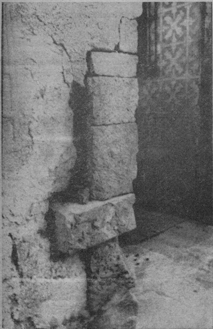
Hace algún tiempo, desde esta misma sección, dimos la voz de alarma sobre peligro de desplome que se observaba en una parte del llamado Arco de la Clastra, en la calle de Velarde. Según parece, un vehículo de grandes dimensiones al pasar bajo el arco rozó uno de sus lados, ahuecando algunas de las piedras, según se observa en las fotografías. Sin embargo, el tiempo ha pasado y el arco continúa en la misma situación de entonces; es más, podría decirse
