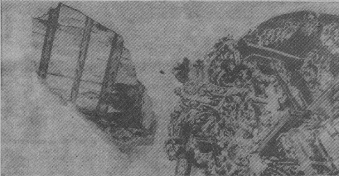
Sobre el techo, tapado provisionalmente, se observa el hueco producido por el hundimiento.
