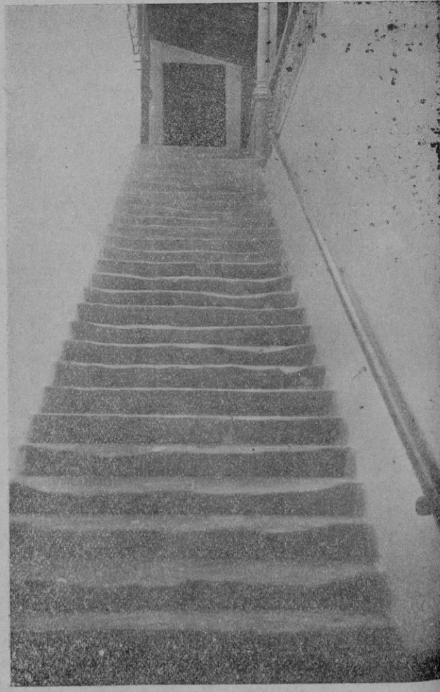
La histórica escalera del Convento de Santa Magdalena, que conserva los mismos peldaños por donde era echada Santa Catalina por el maligno espíritu.
