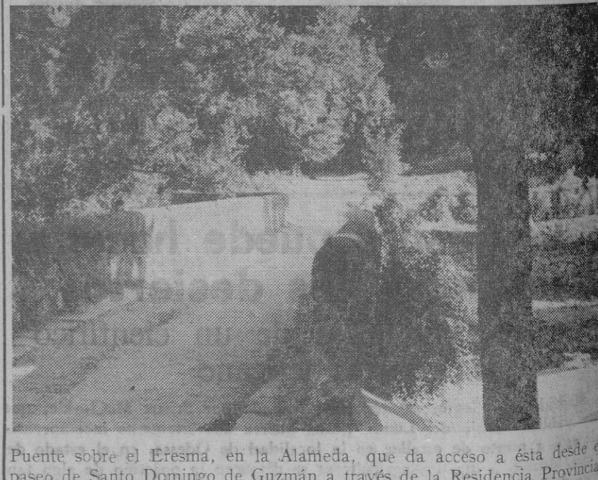
Puente sobre el Eresma, en la Alameda, que da acceso a ésta desde el paseo de Santo Domingo de Guzmán a través de la Residencia Provincial
