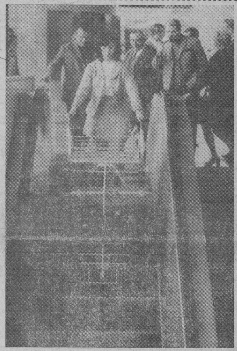
Francfort del Meno.—Es igual si sube o baja, la nueva carretilla portaequipajes se va colocando automática y fijamente sobre los peldaños de la escalera rodante. De modo seguro y cómodo el pasajero vence con su equipaje los varios pisos en el nuevo edificio de recepción del aeródromo de Francfort con sus 69 escaleras rodantes.—(Foto DaD)
