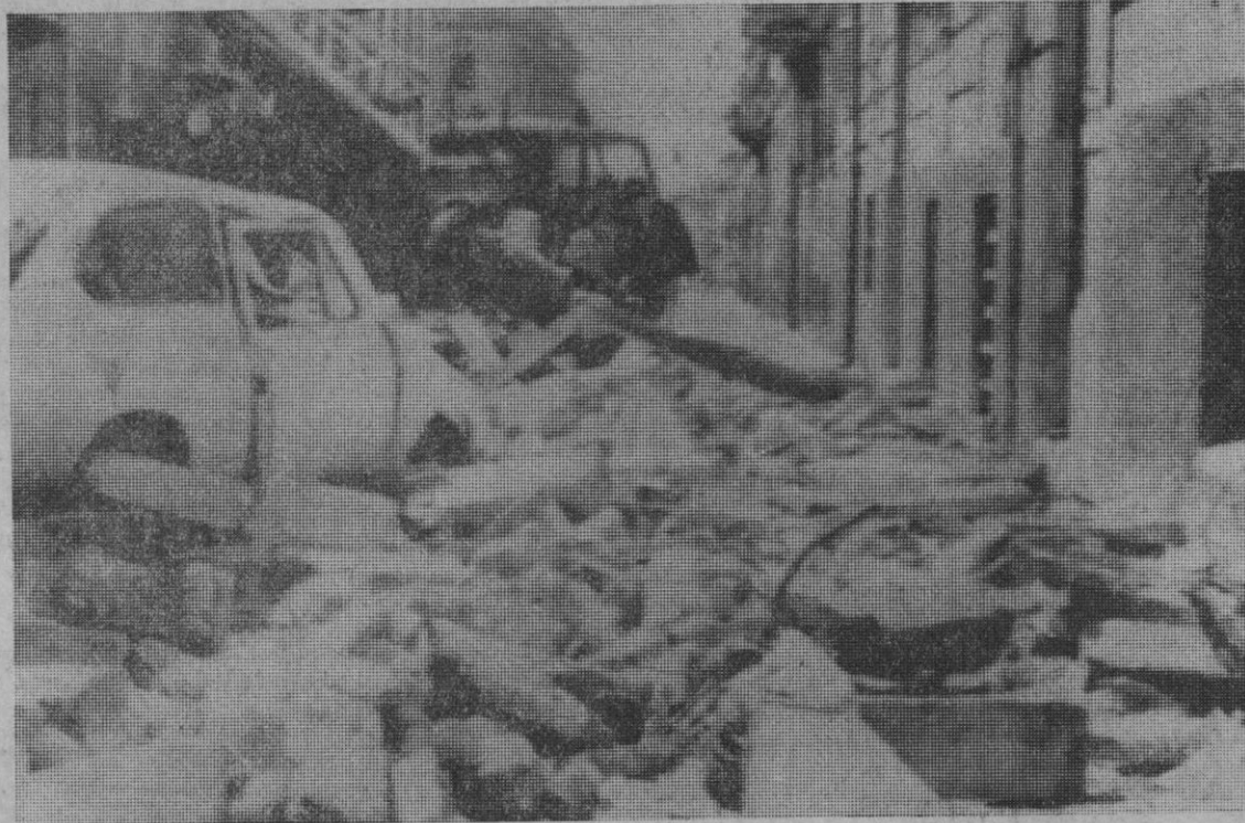
Ancona (Italia).—Una calle del distrito más antiguo de esta ciudad cubierta de escombros y cascotes procedentes del derrumbamiento parcial de algunas casas como consecuencia de una serie de terremotos que comenzaron anoche. Al fondo un coche medio destruido por los cascotes y un coche de bomberos.—(Telefoto AP-Europa Press)
