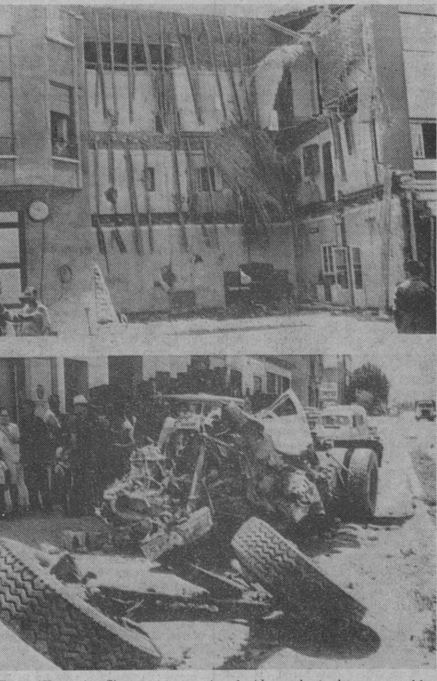
Fraga (Huesca).—Siete muertos y quince heridos es, hasta el momento, el balance del trágico accidente en el que un camión pesado y con remolque chocó brutalmente contra la fachada del «Hotel Galicia» en Fraga. Arriba: estado en que quedó el hotel, con los tres pisos desplomados. Abajo: un montón de hierros retorcidos y las ruedas, es todo lo que queda del camión. (Telefoto AP-Europa Press)
