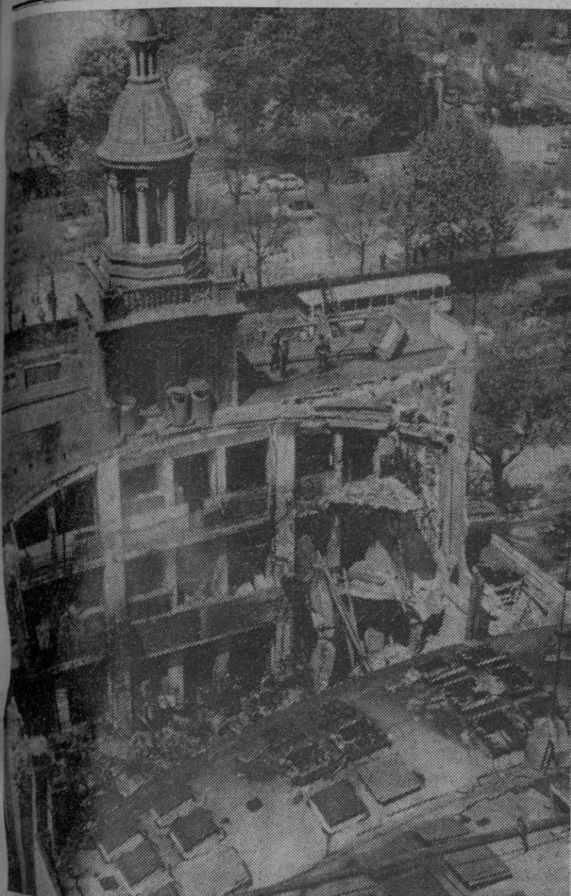
Madrid.—El boquete que el incendio produjo en la sala de frido cuan- diario "ABC", de Madrid, que ha su- peración del benzol en la sala de frido cuan- dichas pérdidas. (Foto Europa Press)
