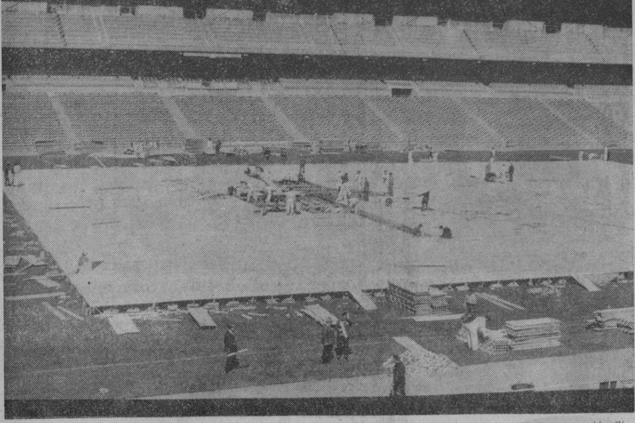
Madrid.—En el Estadio Santiago Bernabéu se llevan a cabo los preparativos de la próxima X Demostración Sindical. Una vista panorámica del interior del recinto deportivo nos muestra cuáles son los preparativos de la que será antología de las anteriores.—(Foto Europa Press)
