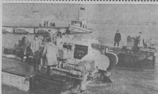
Estos soldados de uno de los regimientos ingleses de Ingenieros estudian cuál es el mejor método de colocar debidamente secciones de un puente flotante. En esta fotografía figuran tres barcas de cincuenta toneladas cada una, y que en conjunto representan una sección de puente de 126 toneladas
