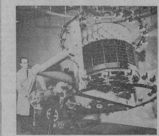
El "Tiros II", segundo de los satélites meteorológicos lanzados por los Estados Unidos, es sometido a pruebas antes de su lanzamiento. El dispositivo especial en el que está montado comprueba el funcionamiento del sistema de estabilización del satélite en condiciones similares a las que se espera encontrará en el espacio en su órbita.
