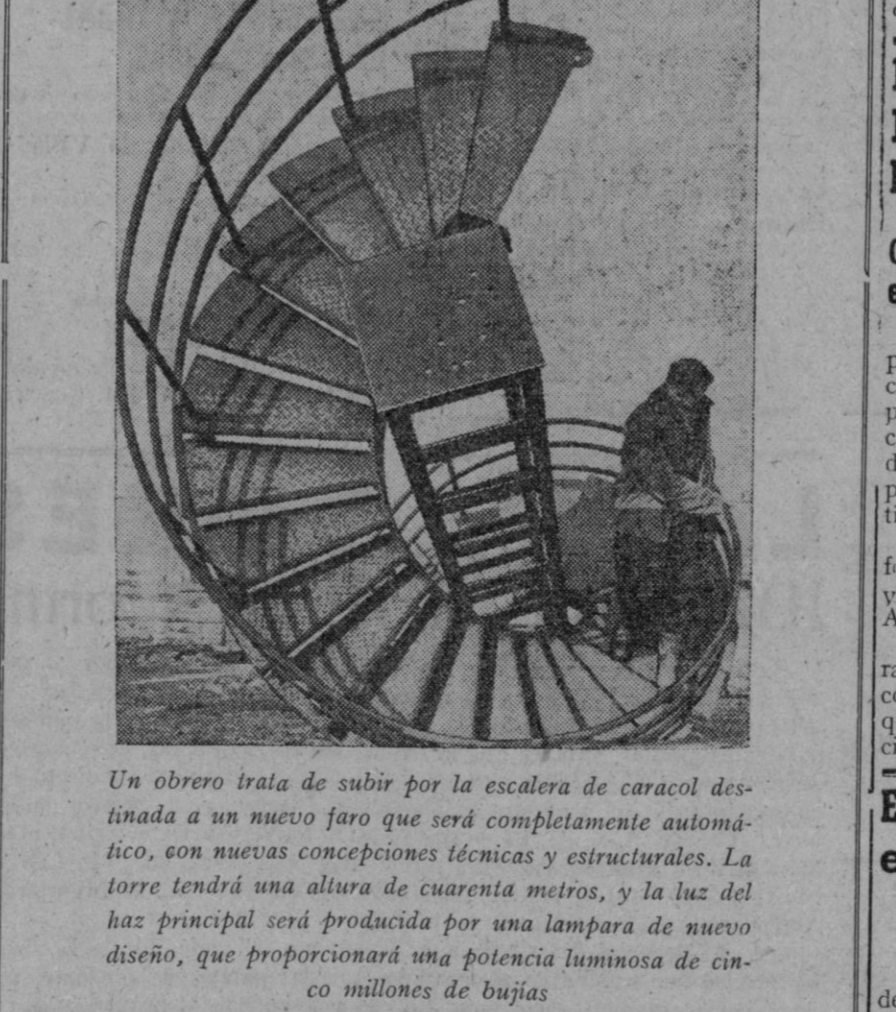
Un obrero trata de subir por la escalera de caracol destinada a un nuevo faro que será completamente automático, con nuevas concepciones técnicas y estructurales. La torre tendrá una altura de cuarenta metros, y la luz del haz principal será producida por una lampara de nuevo diseño, que proporcionará una potencia luminosa de cinco millones de bujías
