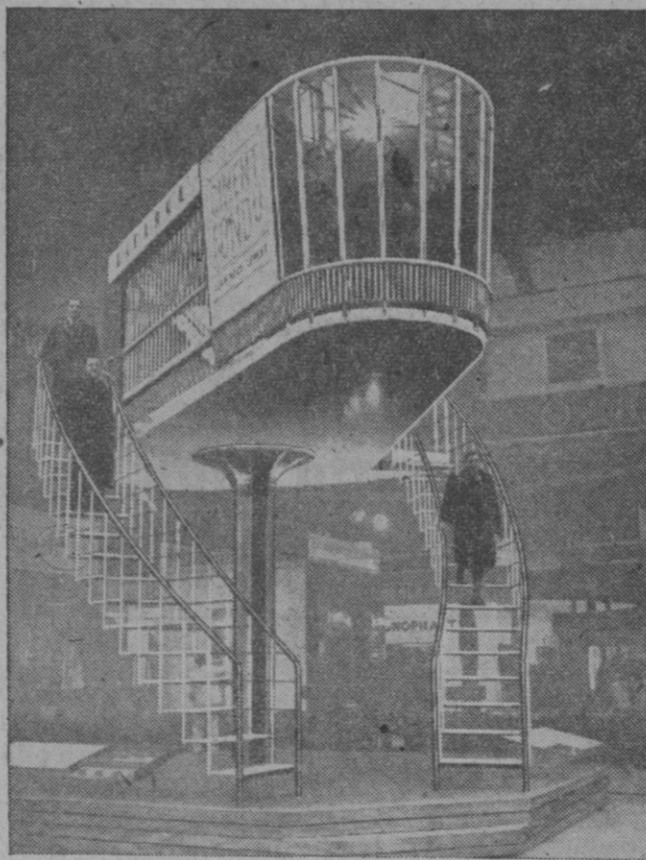
Indudablemente que este artefacto puede presentarse con toda dignidad en una exposición—como en realidad ha sucedido—ya que sus características son de sobra llamativas para que así suceda, y con éxito. Se trata de una plataforma de hormigón, sometida previamente a grandes esfuerzos y que ahí donde la ven ustades fué expuesta a las 24 horas de haber sido construida
