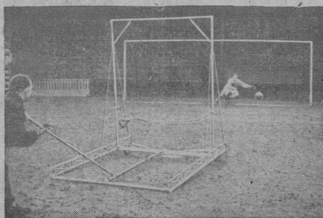
Aparato para entrenar a los porteros de fútbol, que puede lanzar un balón cada diez segundos. Parece que ha tenido gran aceptación, como lo prueba los pedidos hechos a la casa constructora
