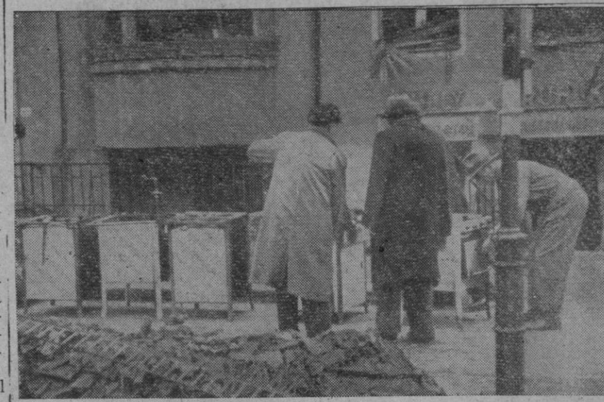
Los servicios municipales de Berlín salvan de las casas bombardeadas cuantos objetos y materiales de construcción consideran útiles para fines ulteriores
