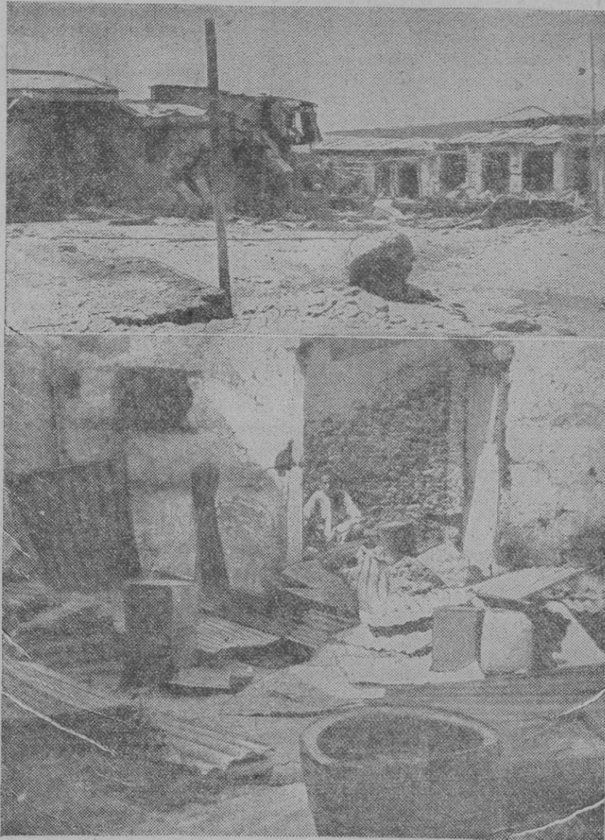
Después del bombardeo aéreo de Harrar. Arriba: un sector de la población destruido. Abajo: las ruinas de una mansión bombardeada, en la misma ciudad
