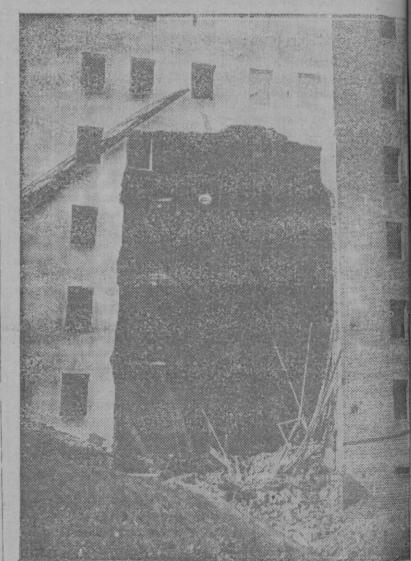
Estado en que quedo la finca hundida en la calle de Alonso Cano. Como se ve, se derrumbaron los pisos inferiores de la parte posterior del edificio, y los pisos superiores quedaron sobre el vacio
