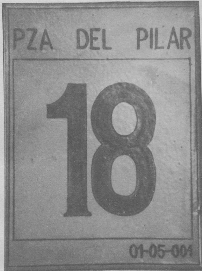
2) Colocación de la placa. — Para la colocación de esta placa podrá utilizarse un soporte intermedio, de acero inoxidable, que irá fijado a la fachada del edificio a que corresponda mediante dos clavos del mismo material, y al que se unirá mediante cemento, cola o silicona la placa de cerámica. De no ser así, podrá fijarse la placa directamente, sin soporte intermedio. En cualquier caso, se situará preferentemente sobre el portal de acceso al que identifica.
