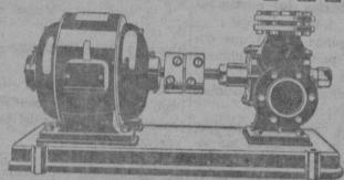
ideal para usos domésticos. 500 litros de agua por hora a 40 metros altura. Acoplada a motores monofásicos de 1/4, 1/6 y 1/8 de HP. que puede conectarse a líneas ordinarias de luz.
