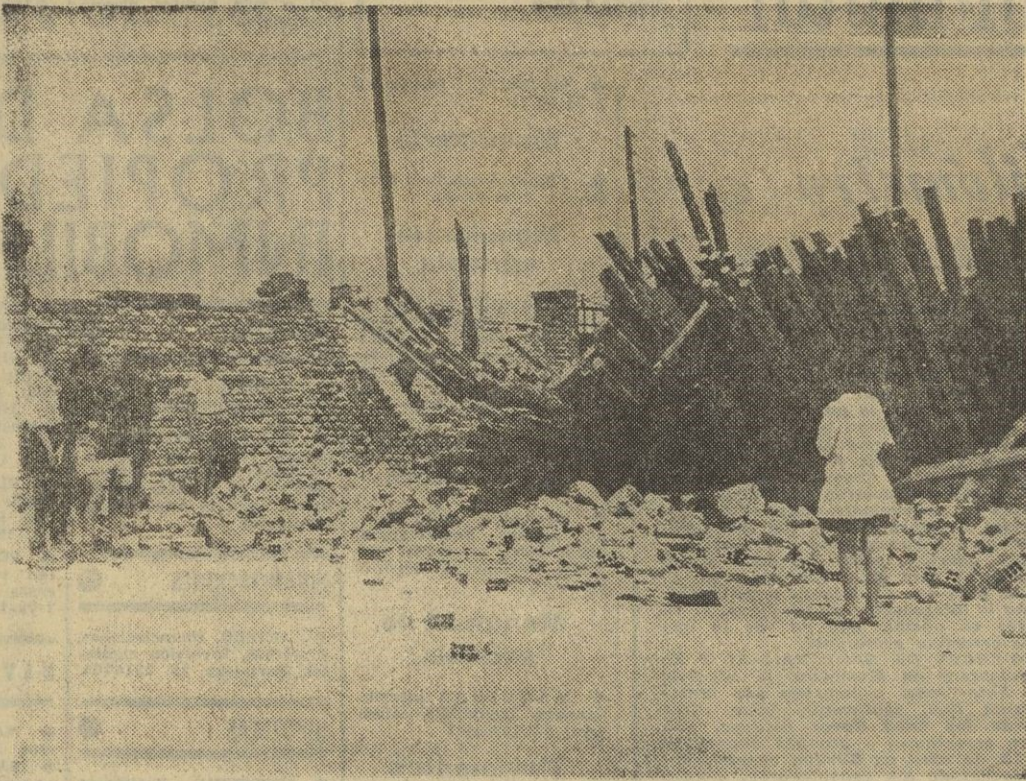
Los cascotes de la pared y las maderas que provocaron su trágico derrumbamiento.
