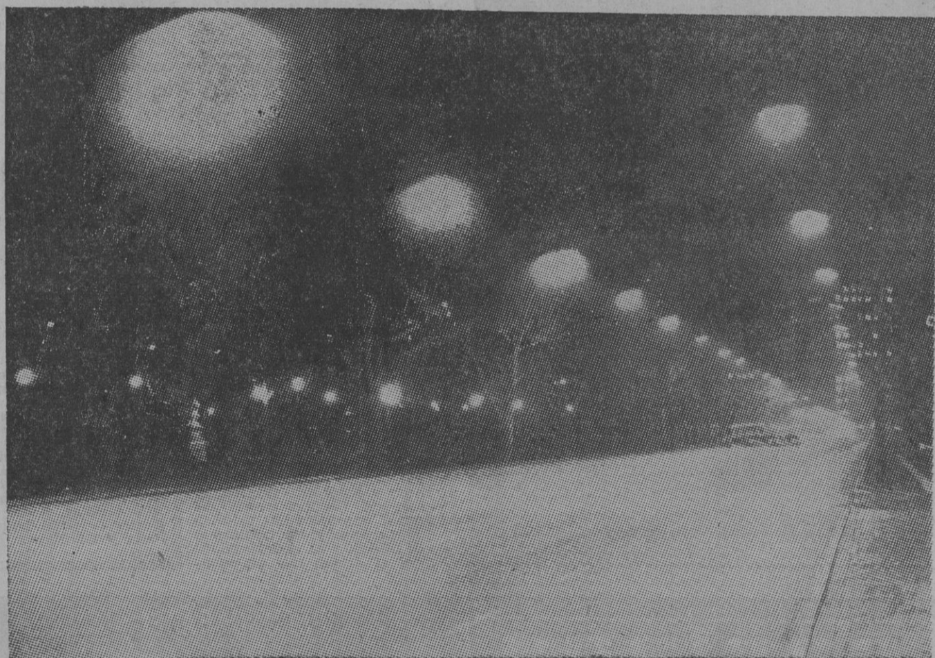
Nueva iluminación del Paseo del Prado con lámparas de Mercurio color corregido OSRAM HQL 400 watos
