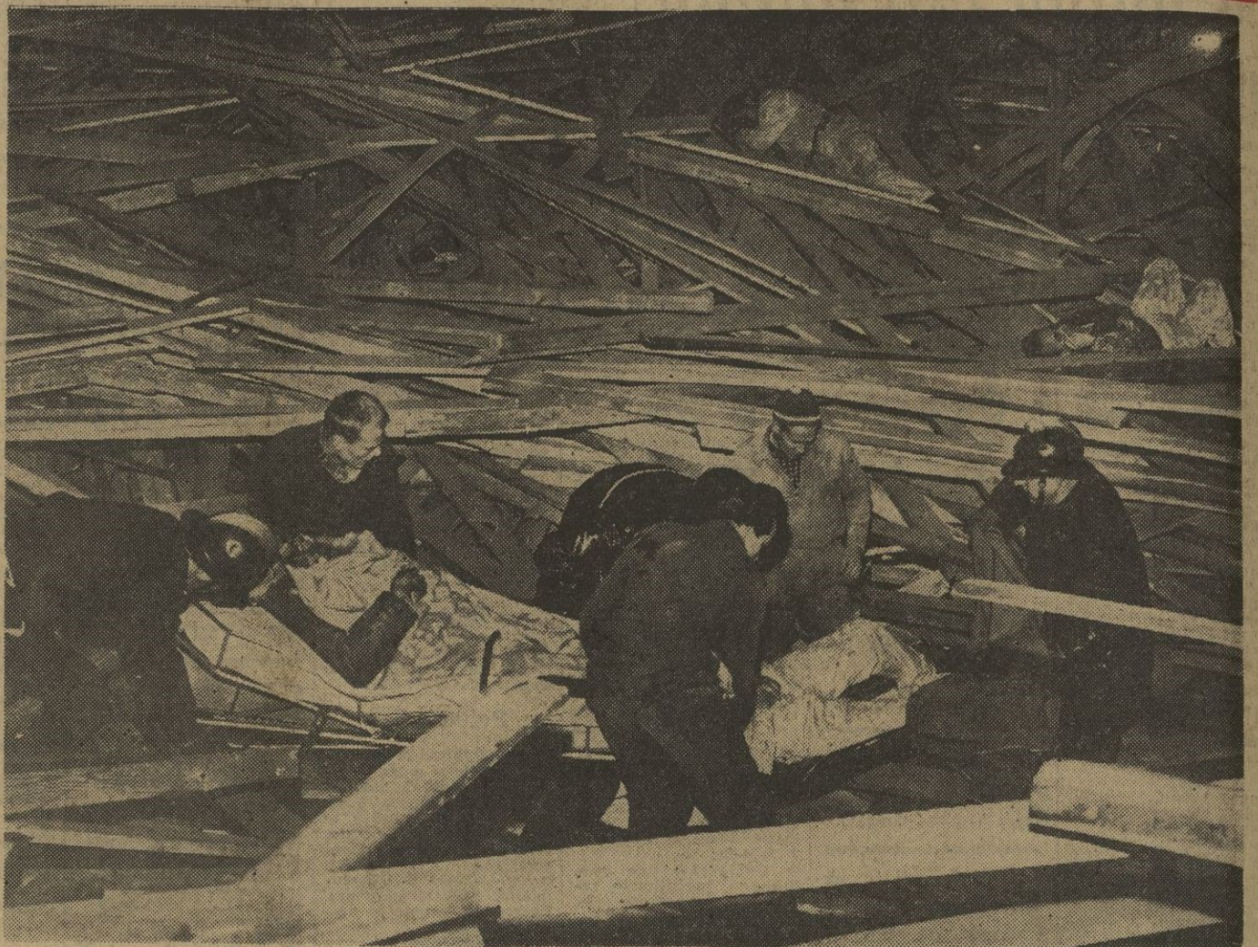
TRAGEDIA EN UN CINE NORUEGO En Oslo se derrumbó el andamiaje instalado para la reconstrucción del cine Coliseum. Diecisiete obreros resultaron heridos. En la foto, uno de los lesionados es trasladado en una camilla a un centro sanitario. Al fondo vemos a otros dos trabajadores que todavía no han podido ser auxiliados. (Foto Europa Press.)
