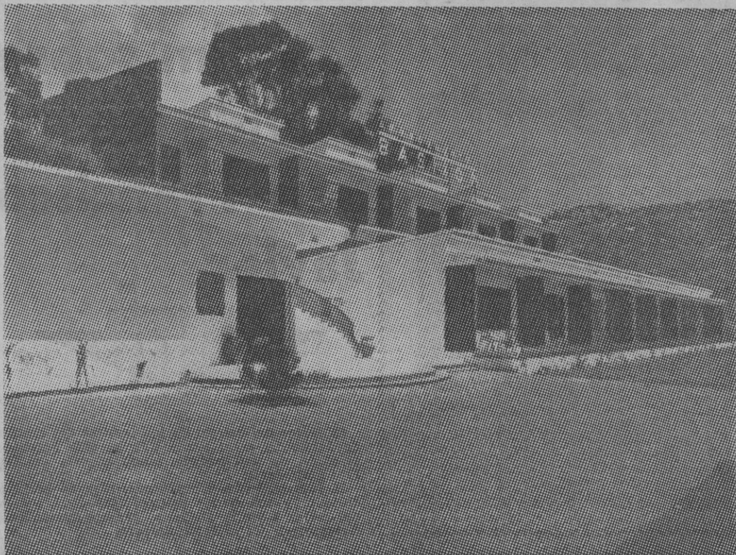
En la zona de aparcamiento, contemplamos esta bonita perspectiva de la obra que comentamos en nuestro reportaje.
