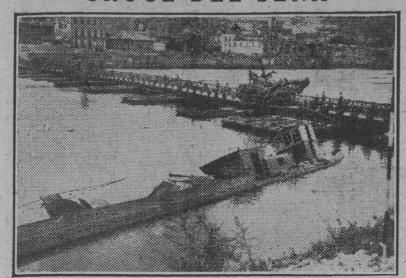
Un carro británico cruza el Scna sobre un puente construído por los ingenieros británicos en substitución del que resultó destruído.
