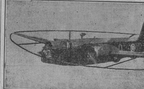
Un Wickers Wellington equipado con el anillo metálico que rodea toda su estructura, para el lobo de los mares, o a sumergirse.
