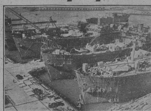
En el puerto de Los Angeles se dan los últimos toques a estos cuatro buques, de 10.000 toneladas cada uno, que serán empleados para el transporte de víveres y material. La forma especial de la proa y la distribución de pesos determina un desplazamiento del centro de gravedad útil, favorable a la mayor velocidad de la nave.
