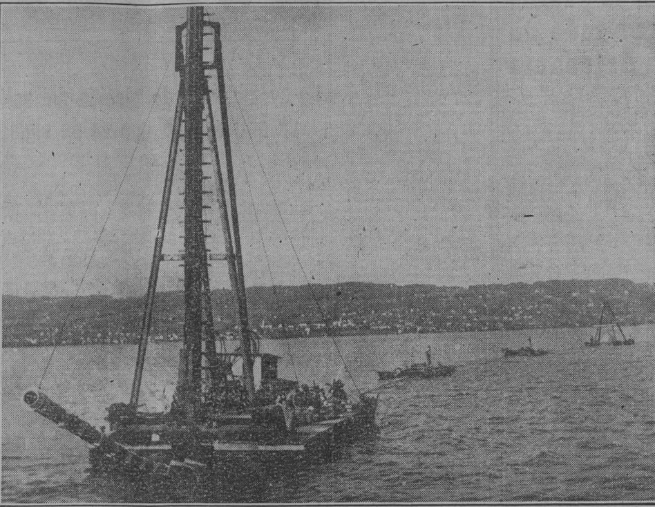
Una casa constructora de Zurich ha colocado, a falta de otros materiales, una moderna tubería de aspiración en el fondo del lago para conducir agua al lugar necesario. Los tubos están contruístos con madera, y según se dice, han dado ya muy buenos resultados. En la foto, la colocación de la tubería en el fondo del lago mediante barcos especiales. (Foto Orbis).
