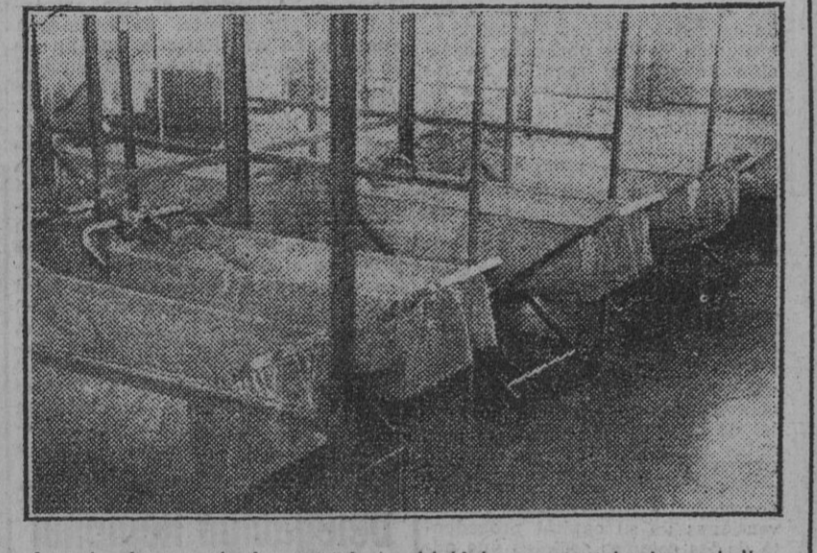
Aspecto de una de las grandes e higiénicas salas donde se hallan instaladas las cunas para los infantes albergados en el moderno Hogar de Auxilio Social.
