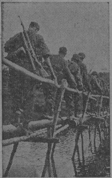
Soldados alemanes, atravesando un río, sobre un puente improvisado para sustituir al destruido por los rojos
