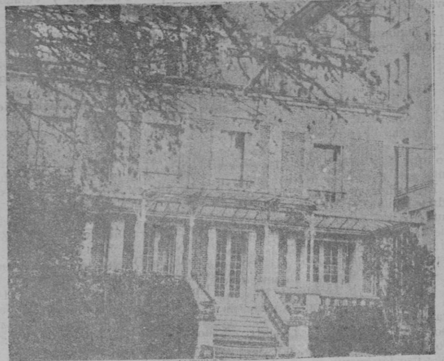
El pabellón del Hotel Savoy en Fontainebleau, donde se ha instalado D. Alfonso con su familia.
