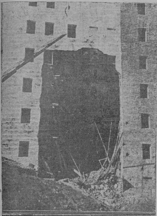
Estado en que quedó la finca hundida en la calle de Alonso Cano. Se derrumbaron los pisos inferiores y los pisos superiores quedaron sosteniéndose
