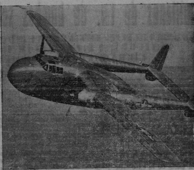
El Fairchild C-82, nuevo avión de carga norteamericano, en pleno vuelo. Lleva dos motores de 2.100 c. v. Tiene un radio de acción de 5.600 km. y una capacidad de carga de 64.75 metros cúbicos.
