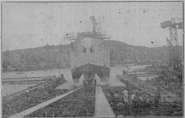
BOTADURA DE UN NUEVO VAPOR MERCANTE. — En los astilleros de la constructora naval de Sestao (Bi Ibaio) ha sido botado el vapor «Dó mine» construído para la compañía Trasméditerránea. El buque deslizando por las gradas.
