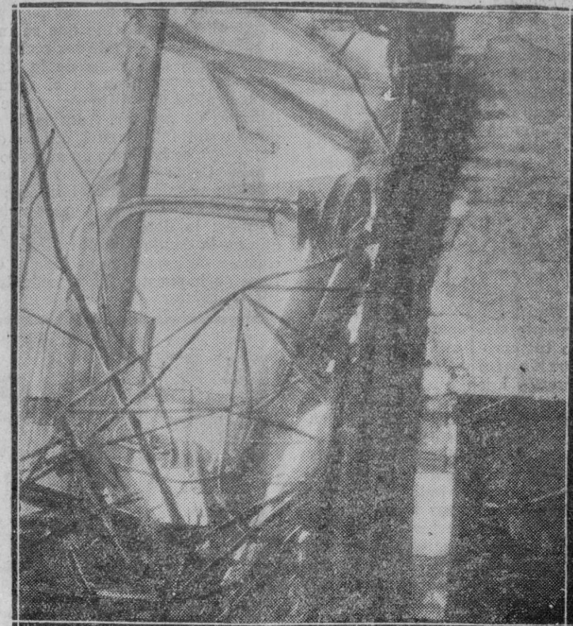
MADRID.—Estado en que quedó el aparato de aviación y el techo de la casa de Claudio 34, después del accidente que costó la vida al piloto y a varios inquilinos de la casa
