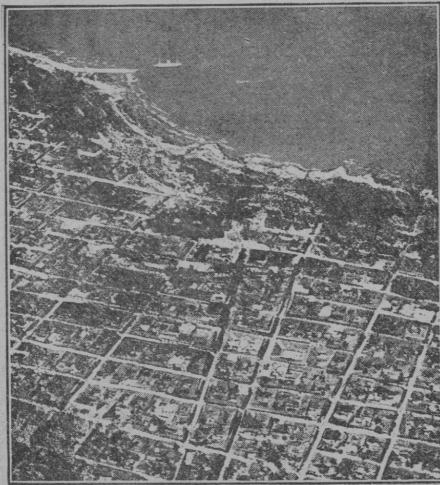
MANAGUA.—Managua capital, de Nicaragua, que ha sido destruida como se sabe por un espantoso terremoto estos días
