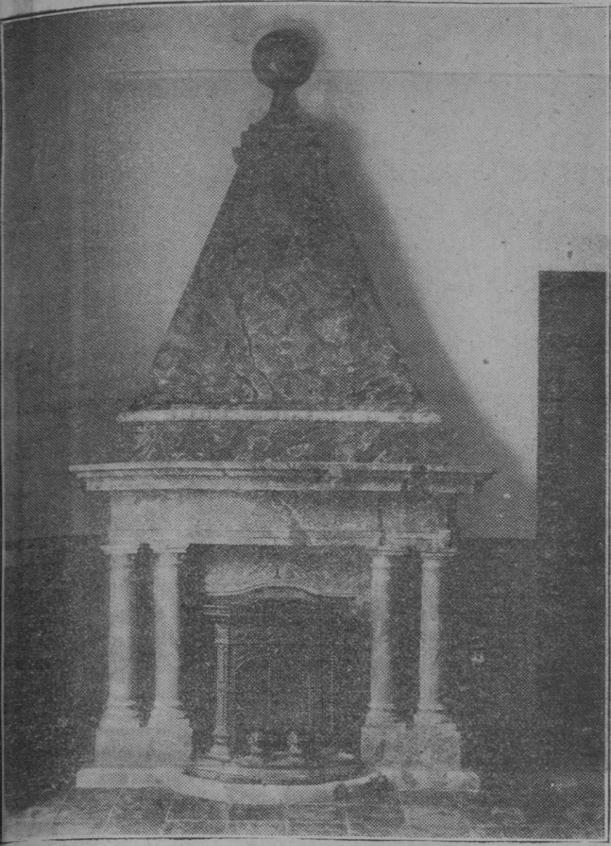
Hermosa chimenea, construida en piedra artificial (marmolina) colocada en la finca So'n Gual (Abocetado y construido por D. Juan Estela)
