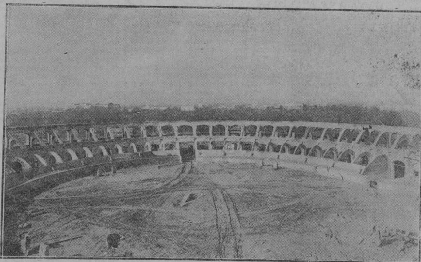
Fotografía de la Nueva Plaza de Toros por la cual se puede formar una idea de la inmensidad de su ruedo y de la gran cantidad de aficionados que podrá albergar.—Sobre lo construido se debe edificar la parte destinada a palcos y andanadas.—(Foto-Vila).
