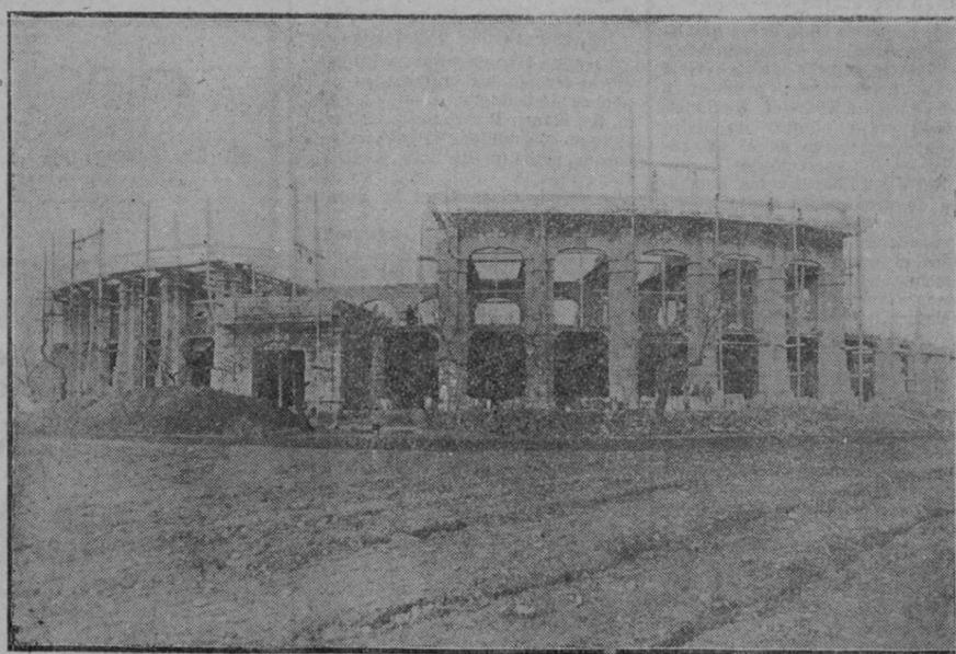
Vista parcial del exterior de la Nueva Plaza de Toros que se construye en terrenos de San Bruy.—En la foto puede apreciarse el comienzo de construcción de una de las cuatro torres exteriores y la casi terminación del primer piso.—La altura de la fachada será superior al pico de los palos de los andamios.—(Foto-Vila).
