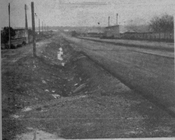
La zanja abierta a la izquierda del Hipódromo de Manacor. No la dejan tan a lo bestia, se recubre asimismo de cemento sus planos inclinados, pero abierta y profunda sí.
