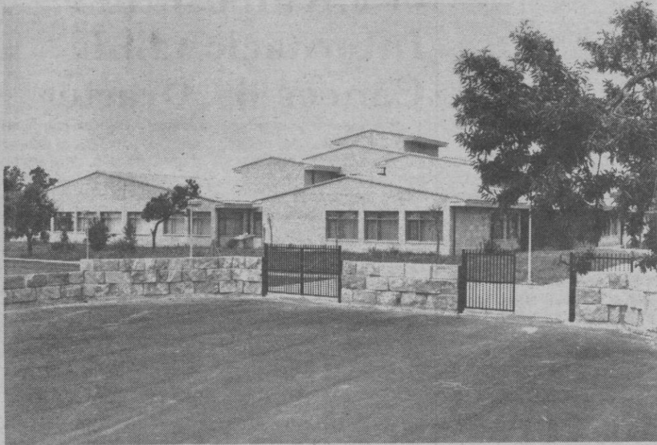
Este es el nuevo edificio de la institución de Formación Profesional «Virgen de Lluc», que se encuentra en la carretera de Sóller, pocos metros antes del desvío hacia el Polígono La Victoria.
