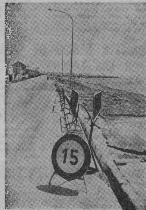
Las obras de Ca'n Pere Antoni a punto de finalizar
