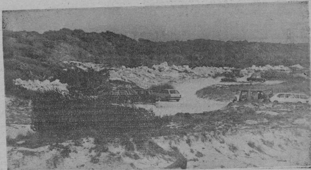
Varios kilómetros de largo tiene este muro que se ha construido con los escombros salidos del Club Náutico.
