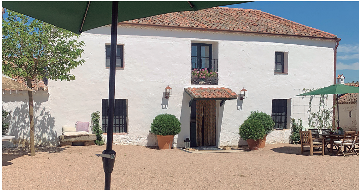
Uno de los edificios del Caserío de Aldeallana.
