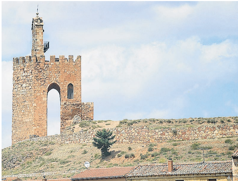
Imagen de las ruinas del recinto del castillo de Ayllón,
