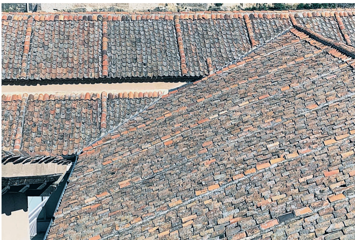
Detalle del tejado del Museo de Segovia, con las tejas puestas con su parte cóncava boca arriba.
