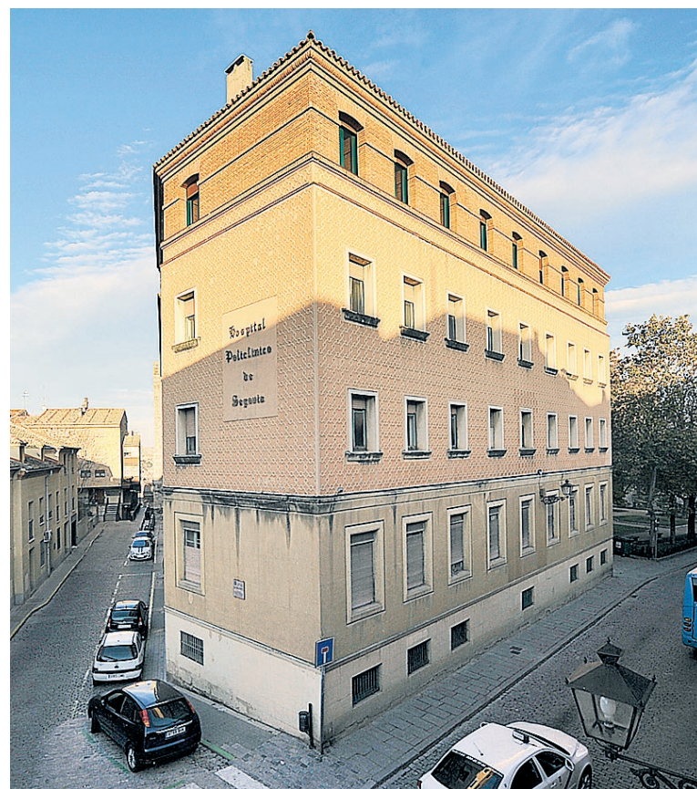
Edificio del Hospital Policlínico que permanece cerrado.
