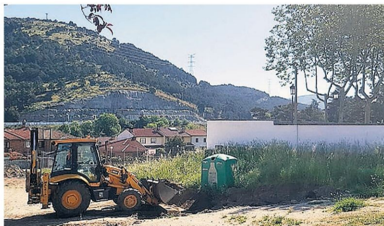
Una excavadora comienza a preparar el terreno.
