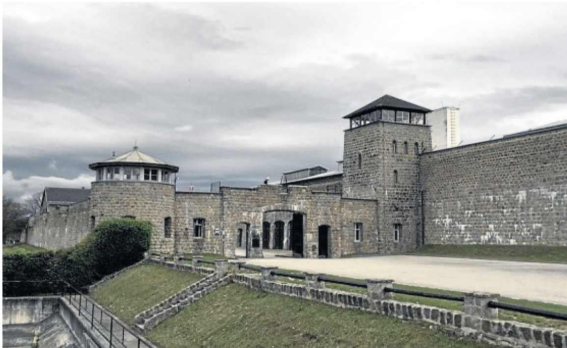
Muros exteriores del campo de concentración nazi de Mauthausen, en Austria.
