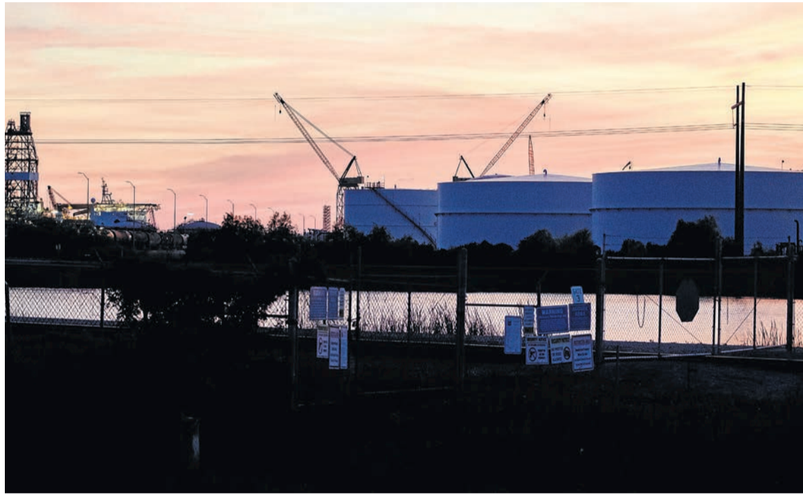
Depósitos de crudo en la refinería de Pascagoula, Mississippi, EEUU.
