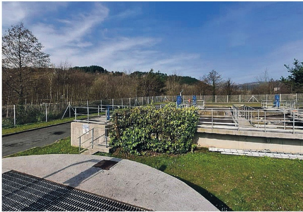
Una estación depuradora de aguas residuales (EDAR).
