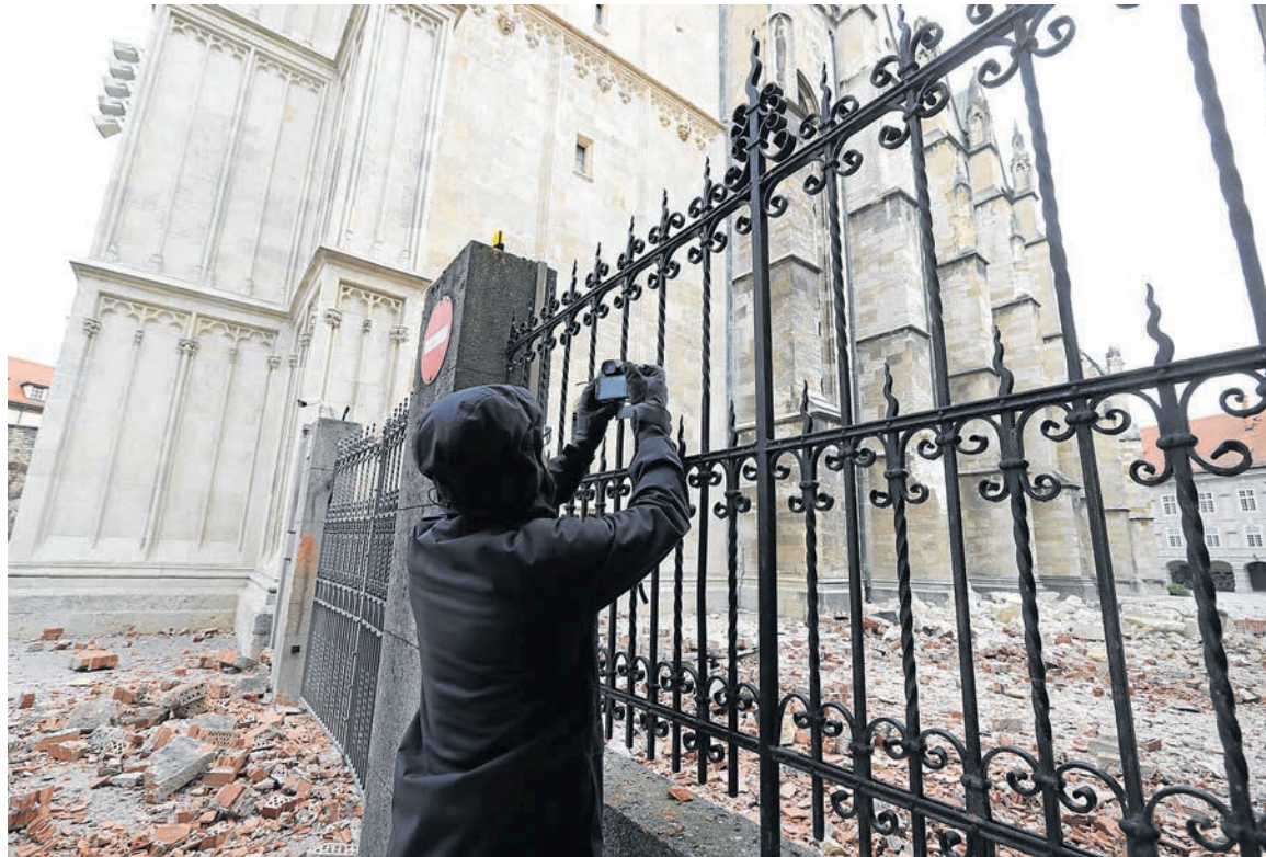
Un vecino de Zagreb fotografía los daños en la catedral.
